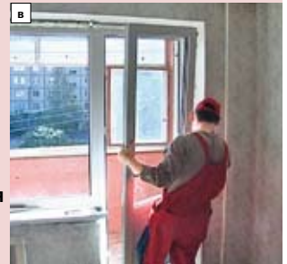
Пластиковое окно освобождают от стеклопакета и устанавливают в подготовленный оконный проём (а). Окно устанавливают в проём на опорные колодки, выравнивают и крепят (б, в). Крепление оконной рамы с помощью металлической пластины — анкера (г). Герметизация наружного шва между рамой и стеной монтажной пеной (д)
