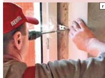
Пластиковое окно освобождают от стеклопакета и устанавливают в подготовленный оконный проём (а). Окно устанавливают в проём на опорные колодки, выравнивают и крепят (б, в). Крепление оконной рамы с помощью металлической пластины — анкера (г). Герметизация наружного шва между рамой и стеной монтажной пеной (д)
