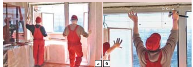
Пластиковое окно освобождают от стеклопакета и устанавливают в подготовленный оконный проём (а). Окно устанавливают в проём на опорные колодки, выравнивают и крепят (б, в). Крепление оконной рамы с помощью металлической пластины — анкера (г). Герметизация наружного шва между рамой и стеной монтажной пеной (д)
